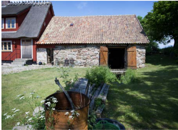
Krapperups vattenkvarn har anor från 1600-talet. Tak och väggar har renoverats under de senaste åren. FOTO: ANDERS MALMBERG
