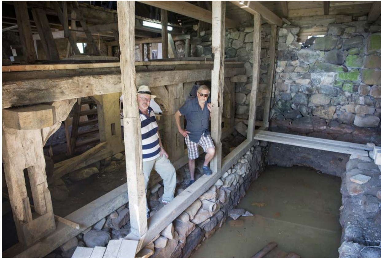
Uppe till höger ska vattnet komma in från en ny dammkista och snurra de vattenhjul som ska byggas. Bo Hansson och Hasse Hansson hoppas få pengar till restaureringsprojektet. FOTO: ANDERS MALMBERG
